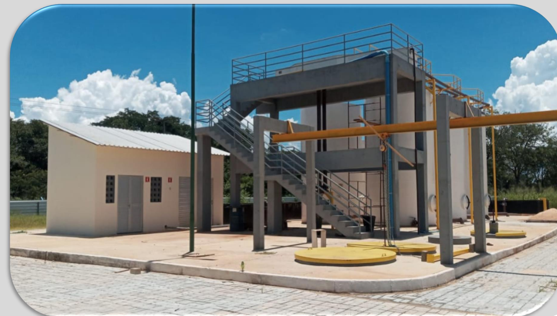
Área da Estação de Tratamento de Esgoto (ETE) – vista estação elevatória.
