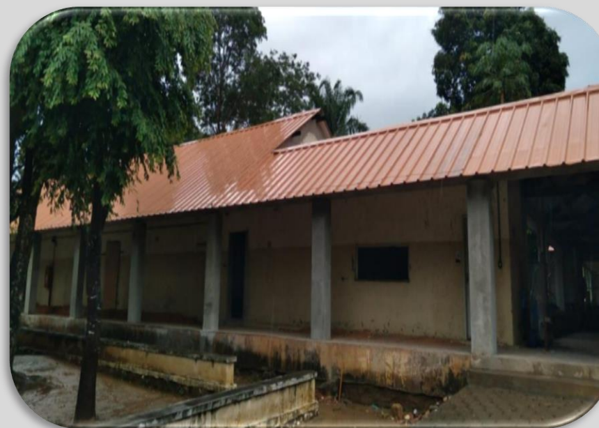
Reitoria – substituição do telhado – Pav.1 (2)
