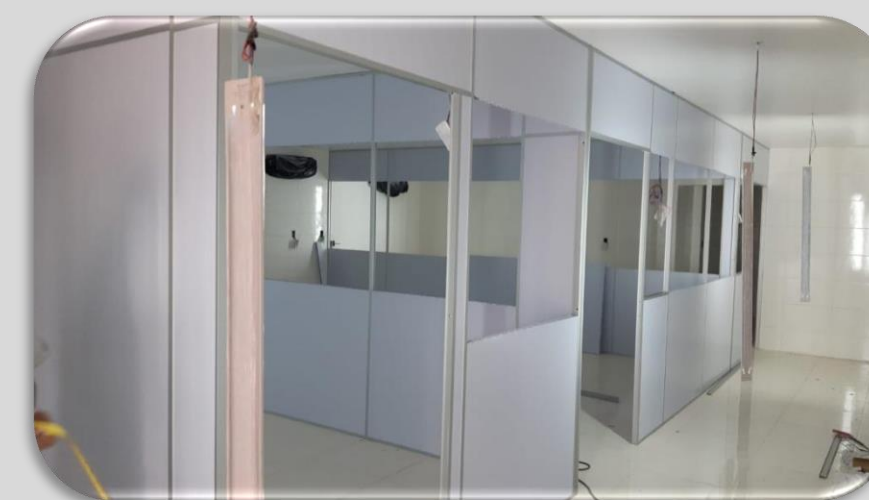
Laboratório de Análises Clínicas – Instalação de divisórias
