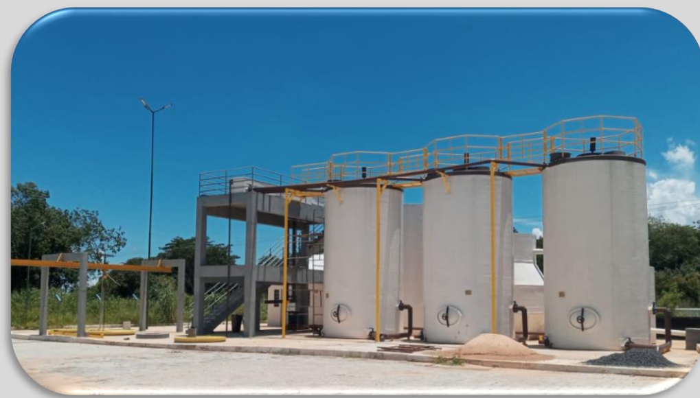
Área da Estação de Tratamento de Esgoto.
