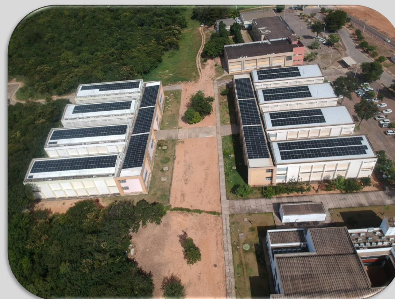
CRES – vista aérea das placas fotovoltaicas instaladas nos Pavilhões de Aulas I e II (2)
