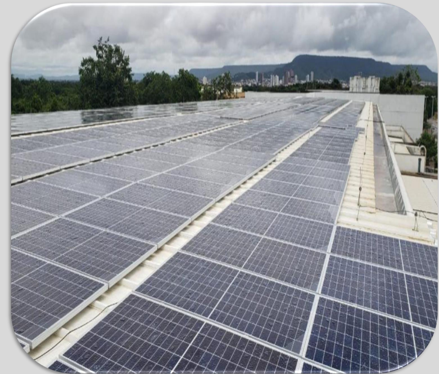
Centro de Convivências do CRES – instalação de placas solares no telhado
