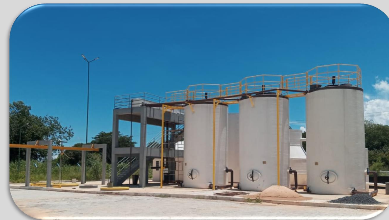
Área da Estação de Tratamento de Esgoto (ETE).
