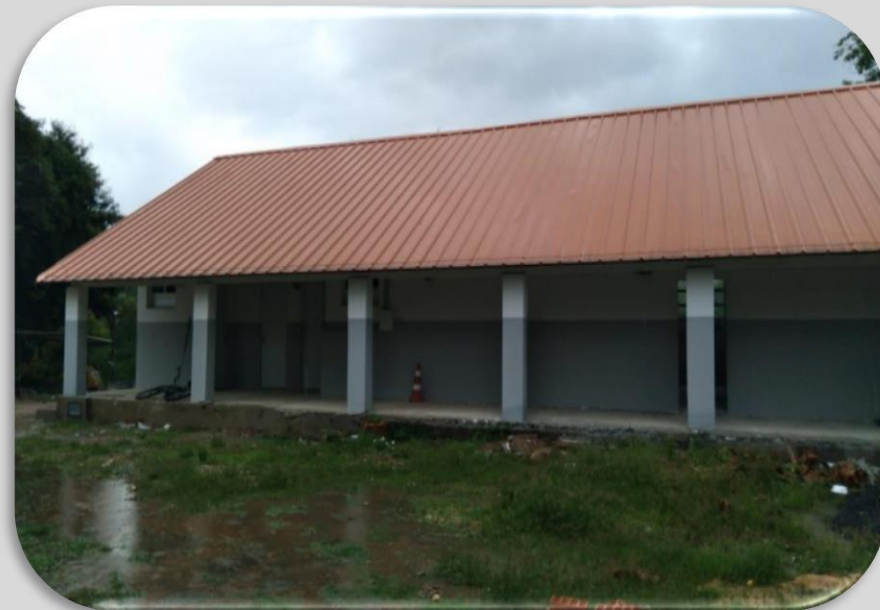
Reitoria – substituição do telhado – Pav.5
