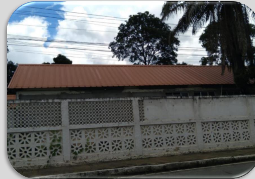
Reitoria – substituição do telhado - Pav. 1
