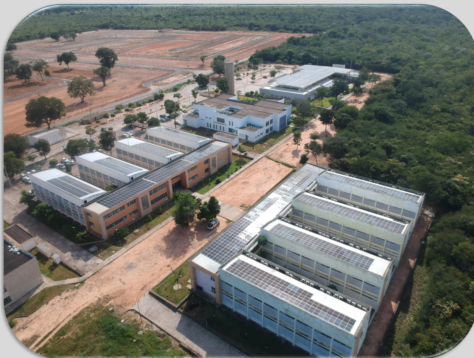
CRES – vista aérea das placas fotovoltaicas instaladas nos Pavilhões de Aulas I e II (1)
