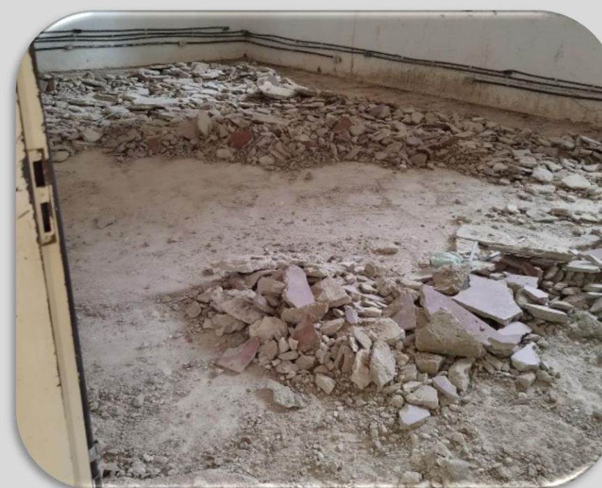
Reitoria – Demolição de revestimento cerâmico
