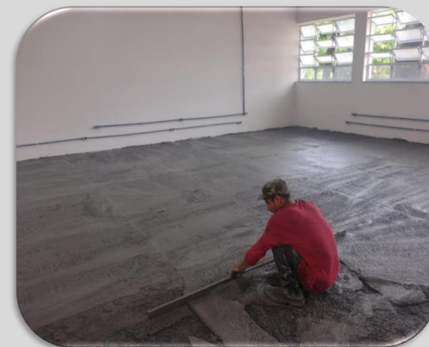
Reitoria – Preparação do piso em alta resistência
